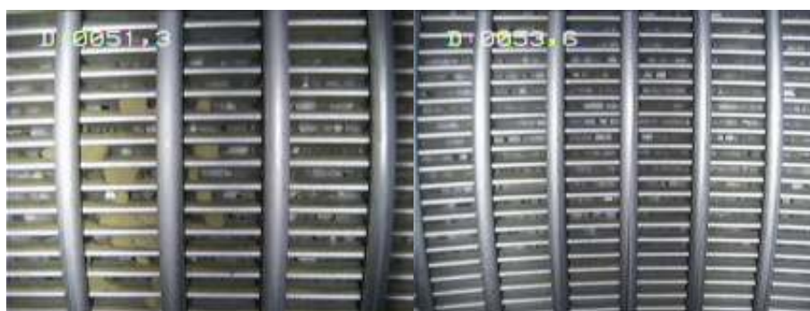
Figure 8 : 2 ème zone crépinée entre -51 et -55 m
