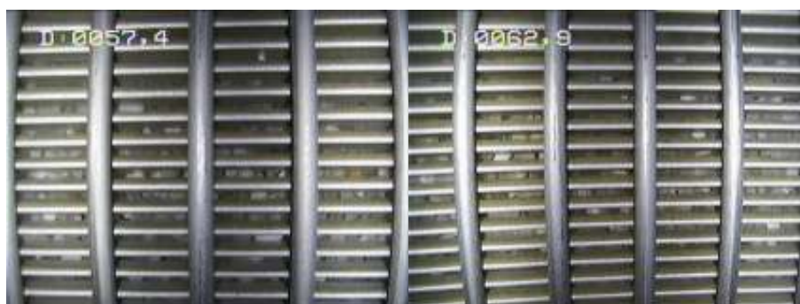
Figure 9 : 3 ème zone crépinée entre -57 et -64 m
